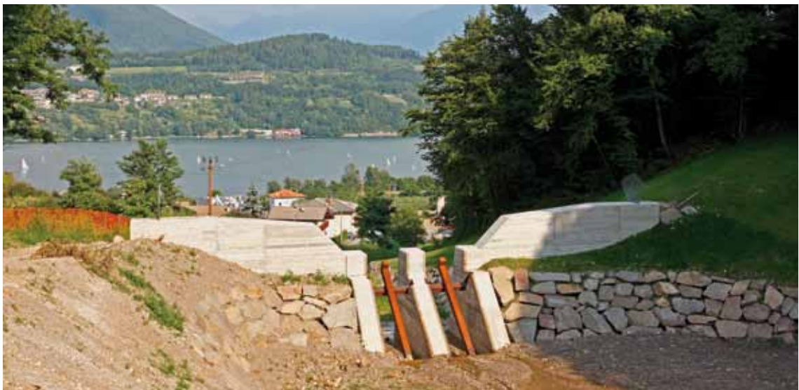
FOTO Opere per il controllo del trasporto solido sul rio Spini; sullo sfondo il lago di Caldonazzo.
