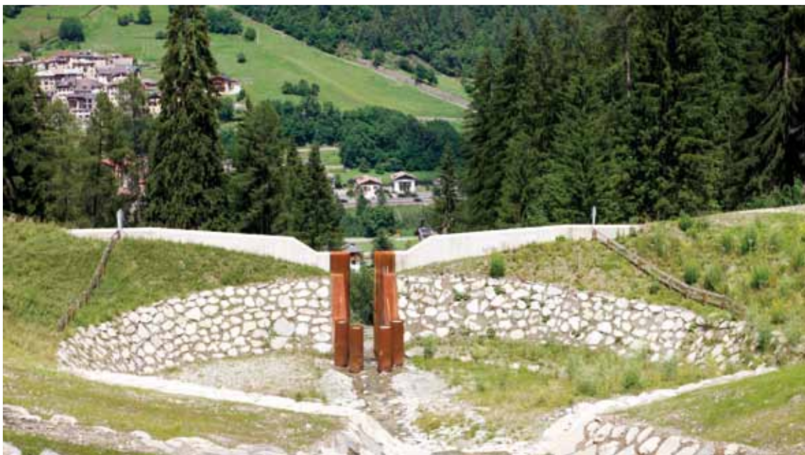
FOTO Briglia filtrante sul torrente Val del Duc a Daolasa (Bacino torrente Noce).
