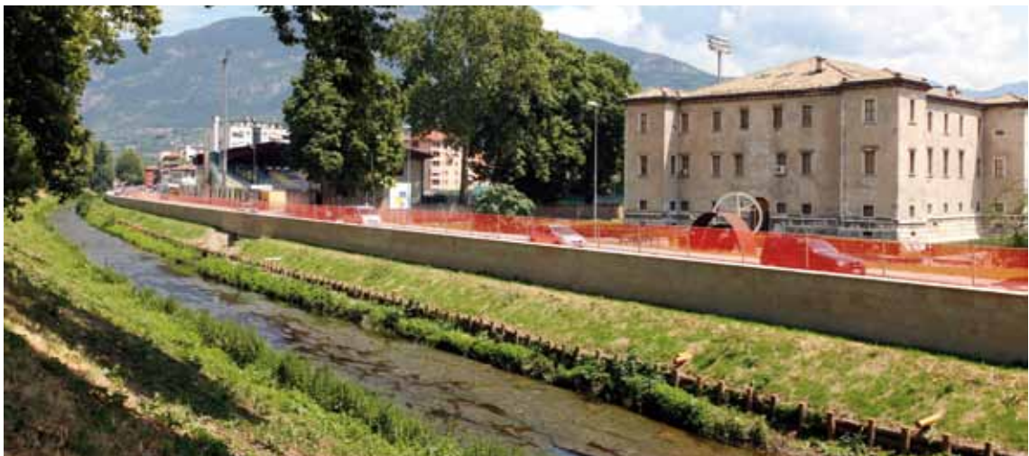
FOTO Arginatura del canale Adigetto, per la messa in sicurezza del quartiere delle Albere a Trento.
