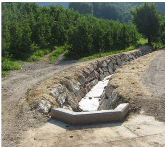
DOPO: la capacità di deflusso dell'alveo è notevolmente aumentata. Per trattenere il materiale solido è presente una piccola briglia filtrante a monte (realizzata in passato).
