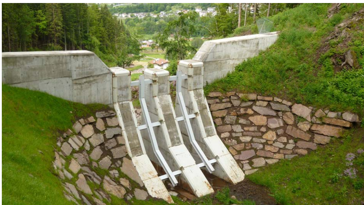
Rio Val Molinara a Baselga di Pinè: briglia filtrante e relativa piazza di deposito, a monte dell'abitato di Campolongo.
