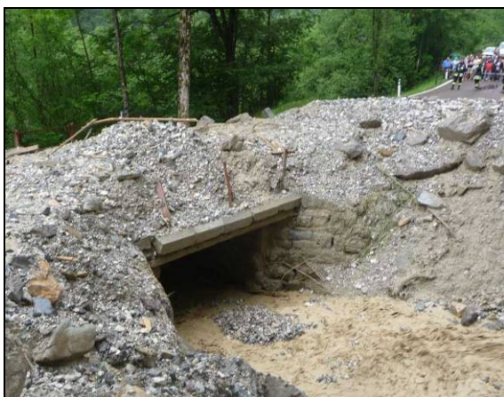
PRIMA: la colata detritica del 10 luglio 2010 aveva raggiunto la strada provinciale della val di Daone, sfiorando un trenino su gomma che stava trasportando un gruppo di pensionati.
