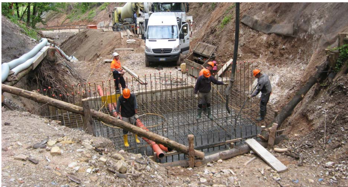
Cantiere di sistemazione idraulica e forestale sul Rio Panizza, a Sorni di Lavis.
