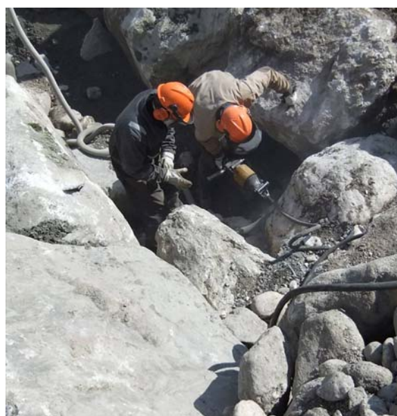
Realizzazione soglie in massi legati e cementati sul Torrente Cisona a Mezzano.
