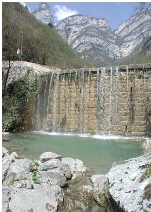
Vecchia briglia di trattenuta e consolidamento ubicata nella parte alta del Torrente Aviana, nella Valle dei Molini
