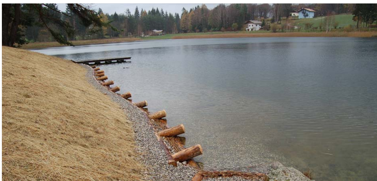
Lago di Lagolo: sistemazione spondale con tecniche di ingegneria naturalistica.
