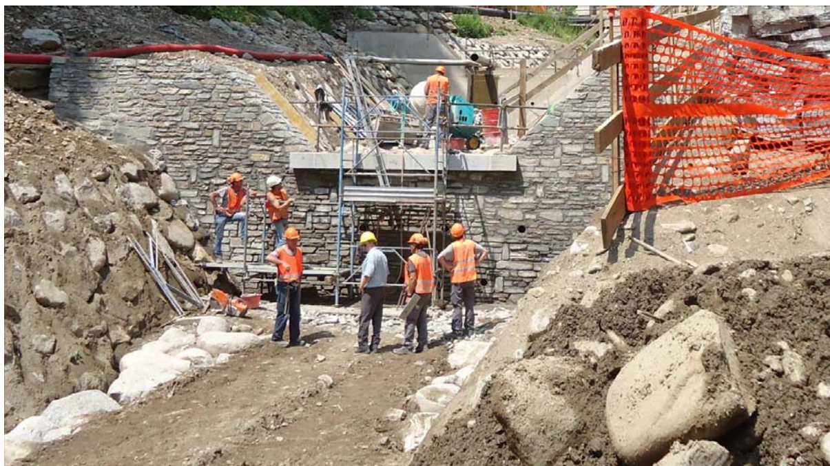
Visita del Medico competente su un cantiere di lavoro (Rio Corda a Pellizzano).
