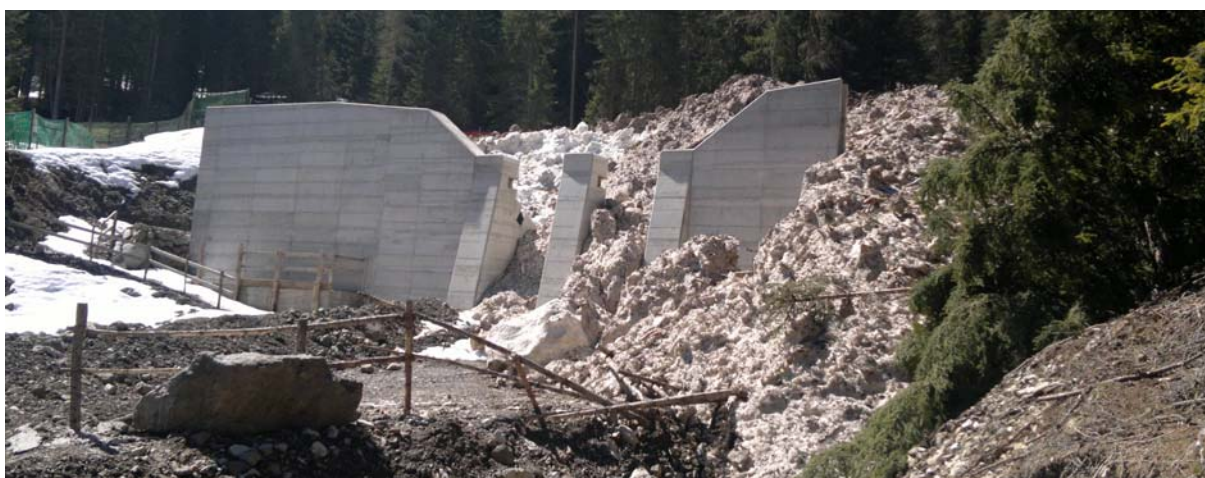
La valanga che ha investito la briglia filtrante in costruzione sul rio Cernadoi, a monte di Alba di Canazei (aprile 2013).
