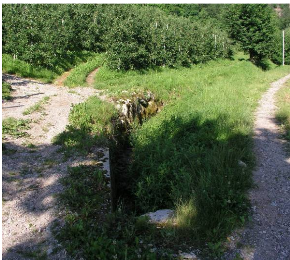
PRIMA: l'attraversamento della strada consorziale prima dell'esecuzione dei lavori.
