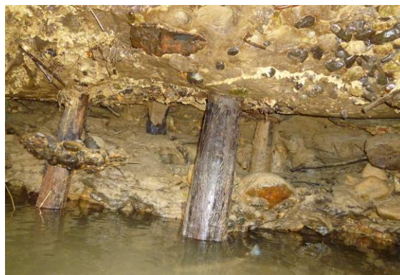
Fondazione della briglia con pali in legno.
