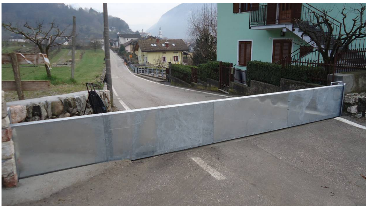
Paratoia che viene chiusa in caso di piena.
