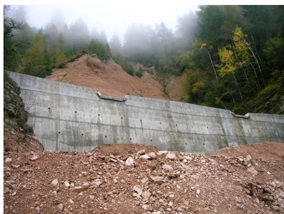
Il corpo della frana e, sotto, il muro di contenimento.
