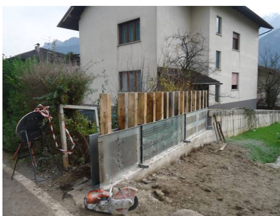
Costruzione delle paratoie a scomparsa nei muri spondali.
