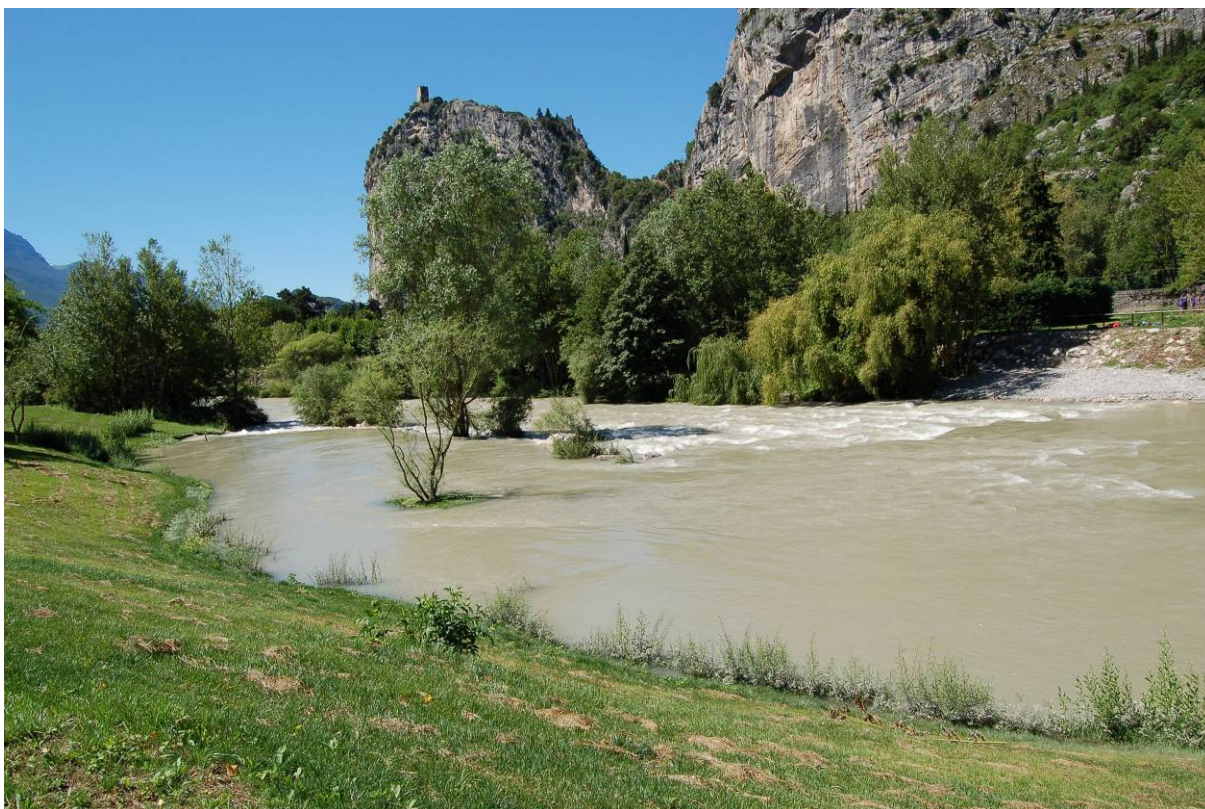
Ripristino dell'area golenale sul Fiume Sarca, in località Moleta (Arco).
