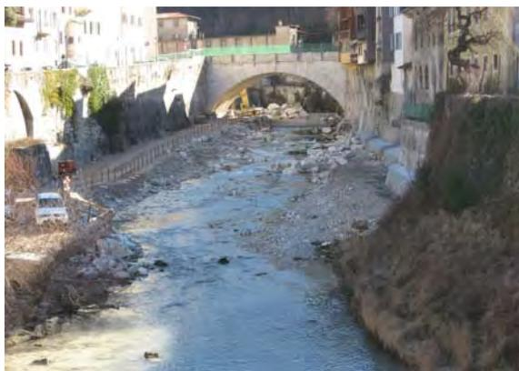
Realizzazione della rampa in massi a valle del ponte
