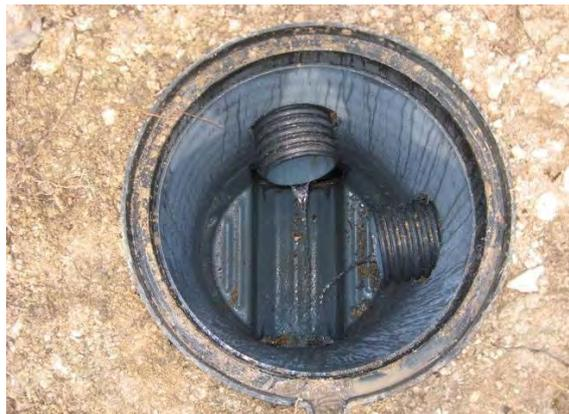
*Particolare costruttivo e di inserimento di un nuovo pozzetto in polietilene*
