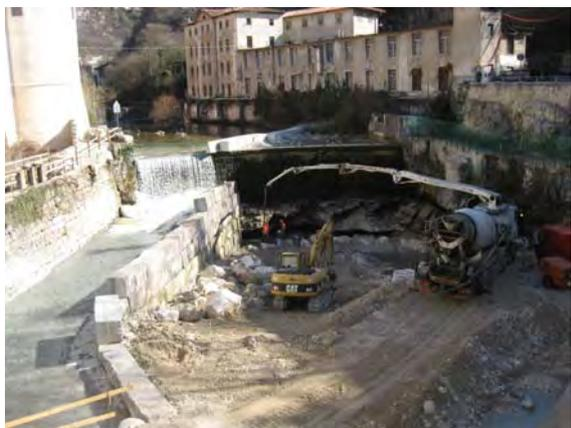
Lavori di consolidamento della briglia a monte del ponte con deviazione della corrente
