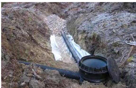
*Posa delle tubazioni drenanti nei pozzetti in sostituzione del materiale danneggiato.*
