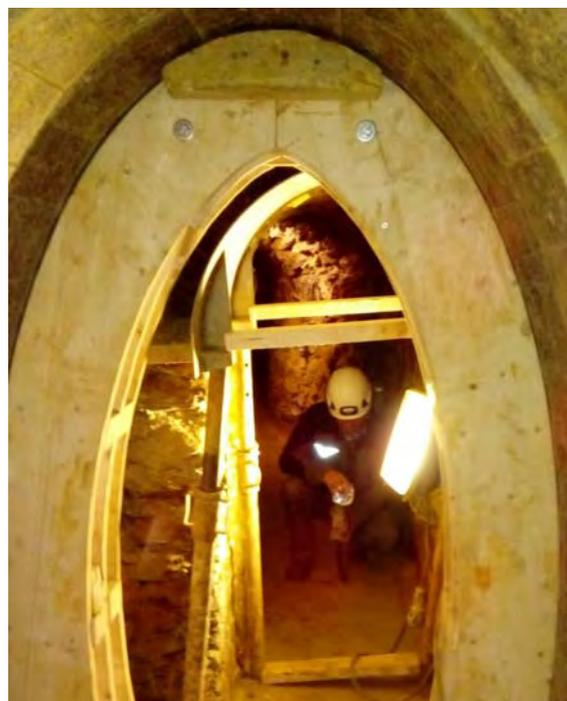
Sono state realizzate delle centine di costruzione in legno, per assicurare il montaggio corretto dei conci che sono stato oggetto di specifica fornitura già tagliati su misura e numerati.
