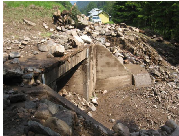
Rio Zocchi II : attraversamento della viabilità forestale ostruito in seguito all'evento.
