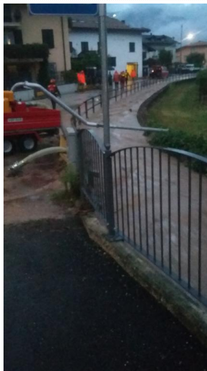
Rio di Fai: intervento con pompe idrovore.
