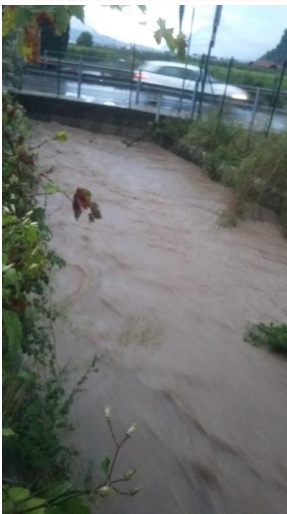
Rio di Fai: effetto di rigurgito causato dal ponte sulla S.S.43.
