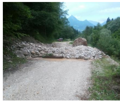
Terzo affluente sinistro del torrente Chieppena: interruzione della viabilità.
