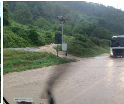
Collettore a valle di Tenna: esondazione lungo la Strada Statale 47.
