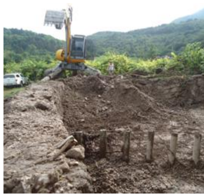
Rio Scanuppia: rimozione materiale dalla piazza di deposito.
