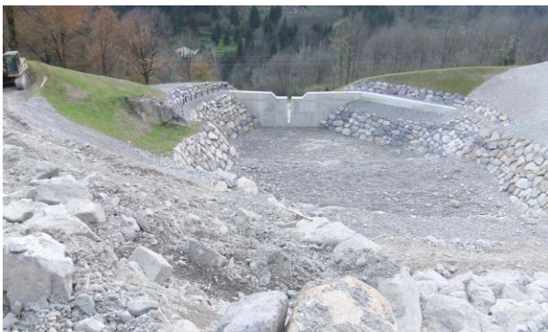
La vasca di deposito sul Rio Recaf nel Comune di Valdaone: a destra, prima dell'evento del 10 agosto, a sinistra al termine dell'evento, completamente riempita dai detriti.
