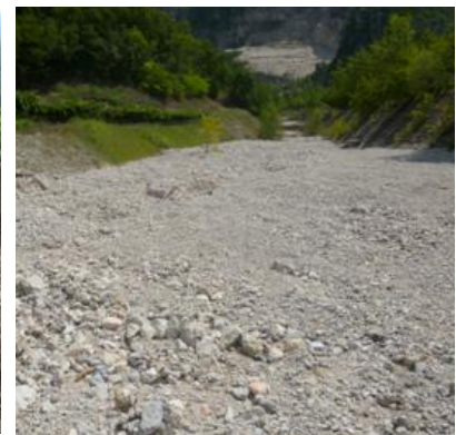
Rio Secco: deposito di materiale in alveo nei pressi dell'area di cava.
