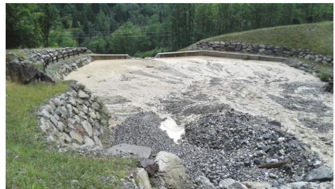
La vasca di deposito sul Rio Recaf nel Comune di Valdaone: a destra, prima dell'evento del 10 agosto, a sinistra al termine dell'evento, completamente riempita dai detriti.
